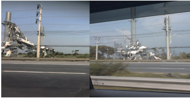
รูปที่ 1 ป้ายโฆษณาขนาดใหญ่ริมถนนพหลโยธิน ช่วงอำเภอน้อย จังหวัดพระนครศรีอยุธยา ได้รับความเสียหายจากเหตุสึนามิ โดยภาพด้านซ้ายแสดงป้ายที่พังทลายลงมา และภาพด้านขวาแสดงป้ายที่ยังคงตั้งอยู่แต่มีรอยร้าวและเสียหายอย่างหนัก
