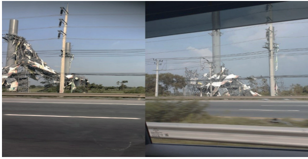
รูปที่ 1 ป้ายโฆษณาขนาดใหญ่ริมถนนพหลโยธิน ช่วงอำเภอน้อย จังหวัดพระนครศรีอยุธยา ได้รับความเสียหายจากเหตุสึนามิ โดยภาพด้านซ้ายแสดงป้ายที่พังทลายลงมา และภาพด้านขวาแสดงป้ายที่ยังคงตั้งอยู่แต่มีรอยร้าวและเสียหายอย่างเห็นได้ชัด
