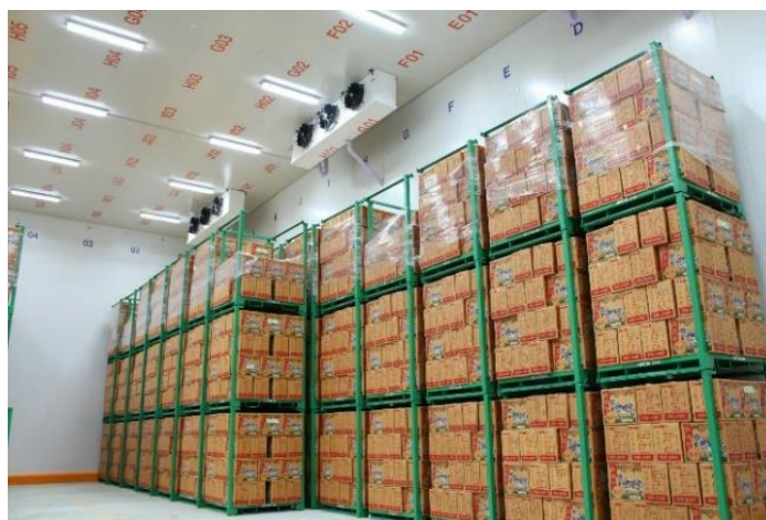
ภาพ 1 พาเลทเหล็กในห้องเย็นสำหรับรับน้ำหนักภายในอุตสาหกรรมอาหาร
