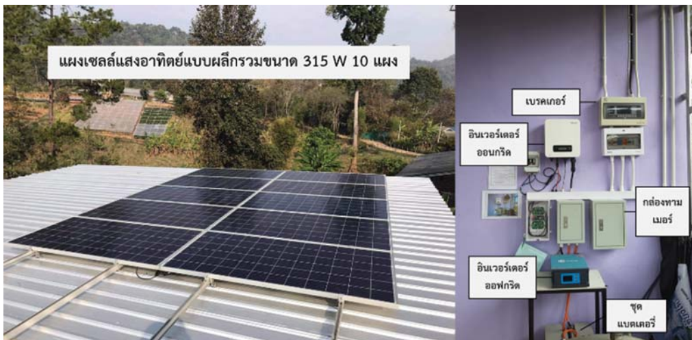
(ข) ระบบผลิตไฟฟ้าพลังงานแสงอาทิตย์
