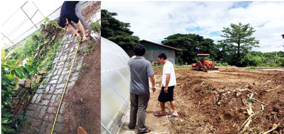
ภาพที่ 1 สภาพพื้นที่สำหรับการก่อสร้างเครื่องอบข้าวแต๋น
