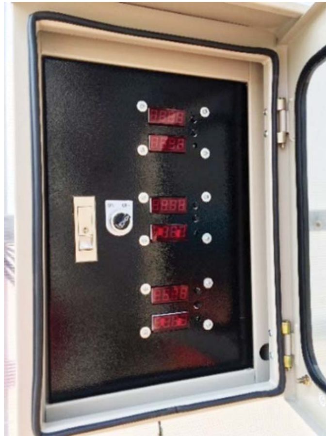
ภาพที่ 2 ชุดวัดอุณหภูมิและความชื้นภายในห้องอบแห้ง
