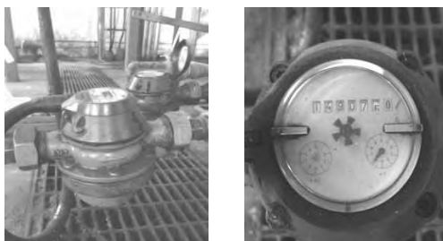
รูปที่ 8 มาตรวัดปริมาณการจ่ายน้ำมันเตา
