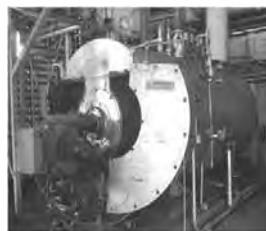
รูปที่ 1 หม้อไอน้ำแบบท่อไฟ ขนาด 3.5, 4 และ 5 ตัน/ชั่วโมง ตามลำดับ
