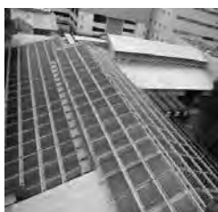
รูปที่ 7 ติดตั้งตัวสะสมความร้อนจากพลังงานแสงอาทิตย์ ของโรงพยาบาลศรีนครินทร์
