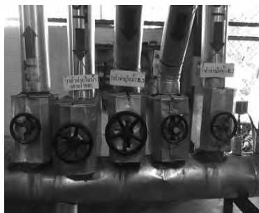
รูปที่ 4 หัวจ่ายแรงดันไอน้ำใช้งาน
