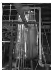
รูปที่ 7 ติดตั้งตัวสะสมความร้อนจากพลังงานแสงอาทิตย์ ของโรงพยาบาลศรีนครินทร์
