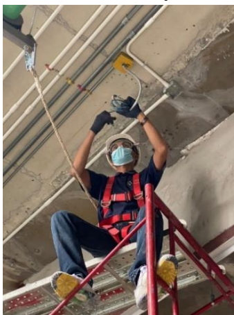
รูปที่ 5 การใช้งานอุปกรณ์ป้องกันภัยส่วนบุคคล (Personal Protective Equipment) ที่ถูกต้องเหมาะสมในงานเดินท่อร้อยสายระบบไฟฟ้าแรงต่ำ
