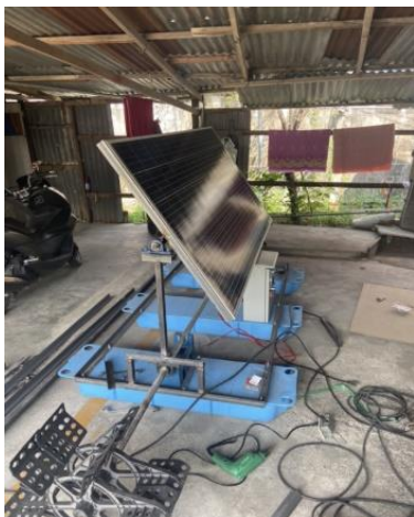
รูปที่ 10 ยึดแผงโซลาร์เซลล์หลักเข้ากับตัวโครงสร้างเครื่องเดิมอากาศ
