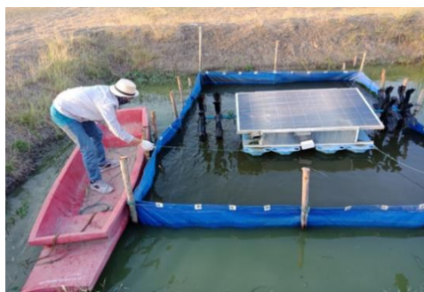
รูปที่ 2 ลักษณะบ่อบทดสอบและการติดตั้งเครื่องเติมอากาศ
