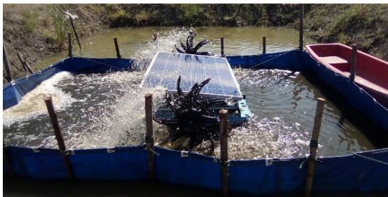
รูปที่ 5 นำเครื่องเดิมอากาศยานแสงอาทิตย์ลงบ่ ทดลองบำบัดน้ำเสีย
