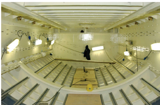
รูปที่ 2 ห้องเก็บแบตเตอรี่ของเรือดำน้ำก่อนบรรจุแบตเตอรี่
