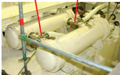
รูปที่ 22 ถังดับความร้อนแบตเตอรี่ (Battery Cooler)
