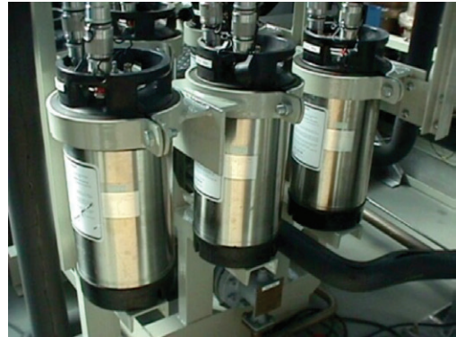
รูปที่ 20 Ion Exchanger
