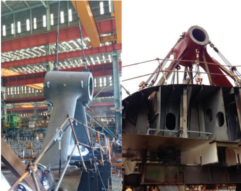
รูปที่ 4 การติดตั้ง Main Strut แบบชั่วคราว
