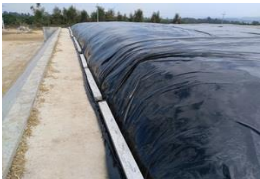
(ง) การใช้พลาสติกดำ ปิดด้านบนเพื่อป้องกันน้ำและอากาศซึมเข้าบ่อ
