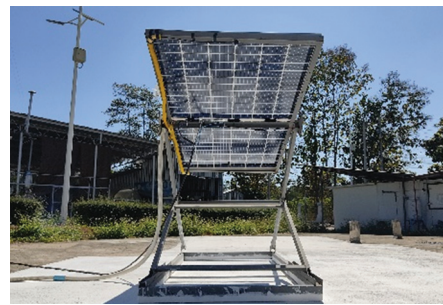
(ก) การติดตั้งแผงเซลล์แสงอาทิตย์ด้านหน้า (ข) การติดตั้งแผงเซลล์แสงอาทิตย์ด้านหลัง รูปที่ 1 การติดตั้งแผงเซลล์แสงอาทิตย์แบบรับแสงสองด้าน (Bifacial PV)
