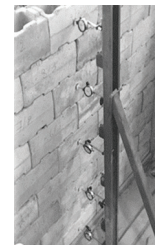
(ข) การติดตั้ง Dial Gauge ในแนวราบ
