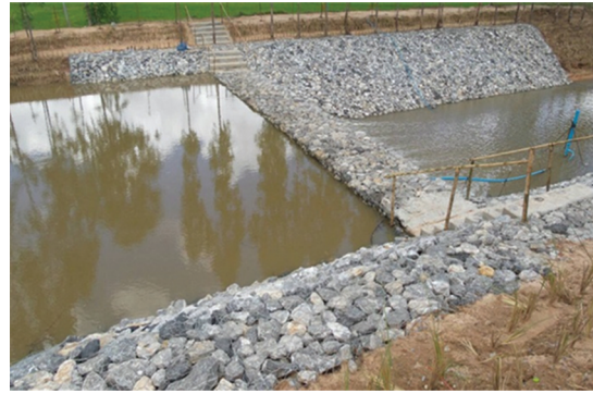
(ข) หลังสร้างฝายชะลอน้ำ
