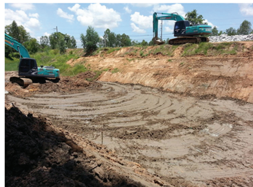
(ข) การบดอัดดินซีเมนต์หน้าและหลังฝายชะลอน้ำ
