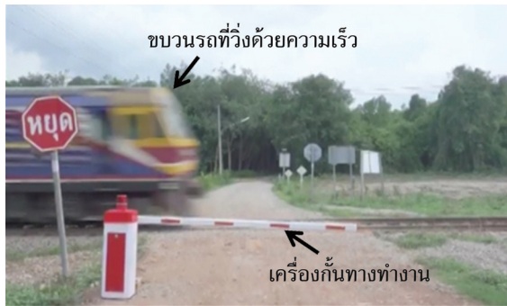
รูปที่ 6 ตัวอย่างการทำงานของเครื่องกั้นทางขณะมีรถไฟเคลื่อนที่ผ่าน
