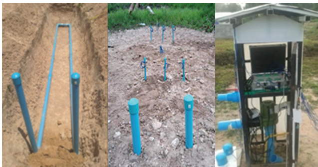
(ข) ท่อใต้ดินแบบตัวยู และการติดตั้งอุปกรณ์วัดอุณหภูมิดิน
