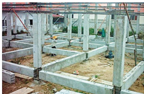
รูปที่ 1 การก่อสร้างโดยชิ้นส่วนคานคอนกรีตสำเร็จรูป (อาคารพาณิชย์ จังหวัดชลบุรี)
