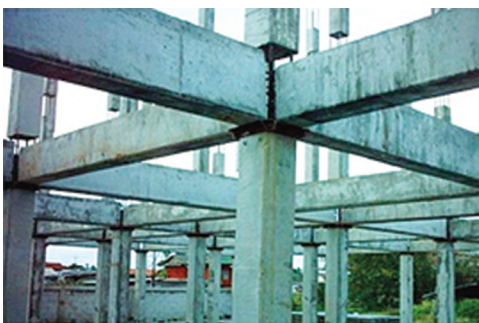
รูปที่ 1 การก่อสร้างโดยชิ้นส่วนคานคอนกรีตสำเร็จรูป (อาคารพาณิชย์ จังหวัดชลบุรี)
