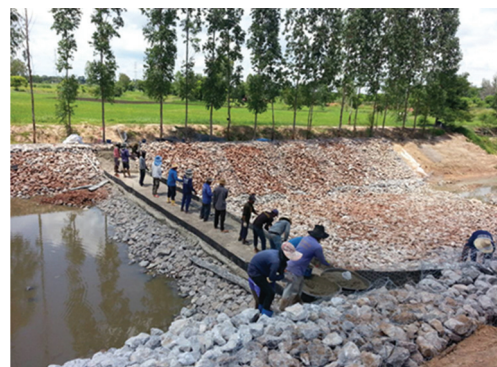
(ง) การวางกล่องเก็บน้ำบนบรรจุหินใหญ่
