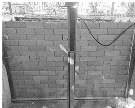
(ก) กำแพงก่ออิฐประสาน
