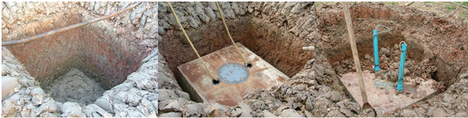
รูปที่ 6 การขุดหลุมเพื่อฝังถึงโลหะ
