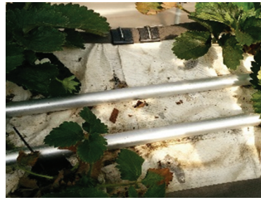
(ง) ท่อน้ำเย็น
