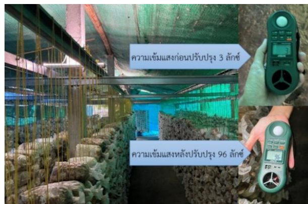
ภาพที่ 5 ติดตั้งระบบส่องสว่างปรับปรุงความเข้มแสงภายในโรงเพาะเห็ดต้นแบบ
