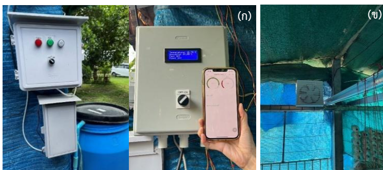
ภาพที่ 3 (ก) ตู้ควบคุมและหน้าจอแสดงผลอุณหภูมิและความชื้น (ข) ติดตั้งพัฒนระบบอากาศ
