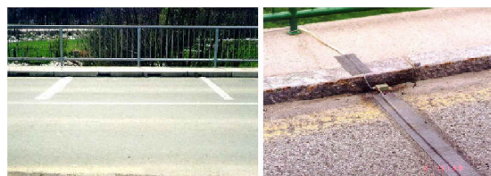
รูปที่ 1 อุปกรณ์ตรวจจับเพลลาแบบติดตั้งบนผิวทาง [3]
