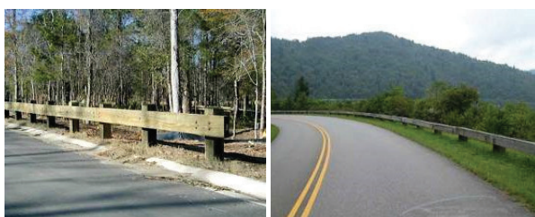
รูปที่ 1 ตัวอย่างราวกันอันตรายชนิดที่ทำจากไม้ที่นิยมติดตั้งบนถนนเชิงนิเวศน์ [11]
