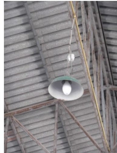
รูปที่ 2 ก่อนเปลี่ยน : หลอดปล่อยประจุความดันไอสูง ขนาด 400 วัตต์ พร้อมโคมสะท้อนแสงฉาบในสีขาว
