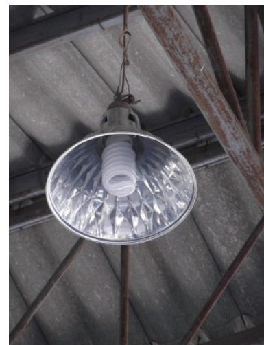
รูปที่ 3 หลังเปลี่ยน : หลอดประหยัดพลังงานขนาด 110 วัตต์พร้อมโคมสะท้อนแสงฉาบบนสีเงิน
