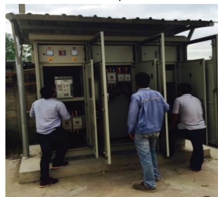
รูปที่ 7 ตรวจสอบการทำงานของระบบควบคุมค่าตัวประกอบกำลัง
