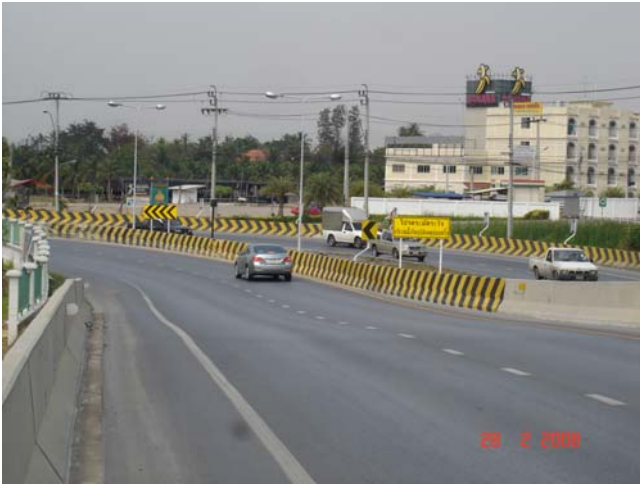
รูปที่ 4 บริเวณโค้งอันตราย
