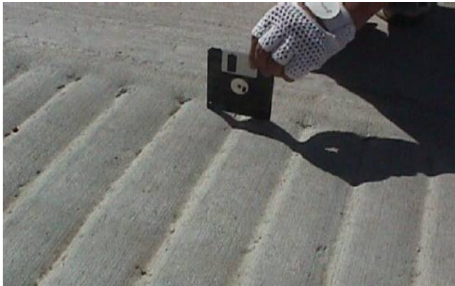
รูปที่ 6 แถบเสียงสะท้อนไหล่ทางแบบหล่มผิว [8]
