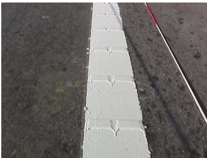
รูปที่ 7 แถบเสียงสะท้อนไหล่ทางแบบขกสัน [8]
