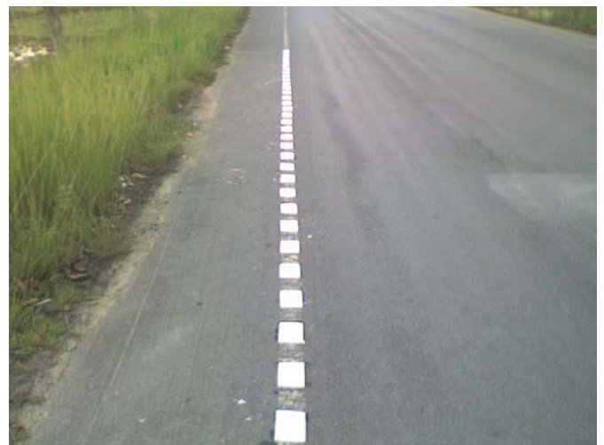
รูปที่ 13 แถบเสียงสะท้อนไหล่ทางที่ติดตั้ง
