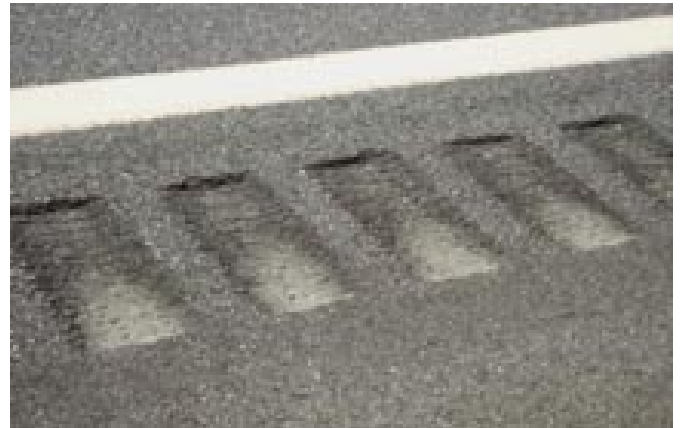
รูปที่ 4 แอบเสียงสะท้อนไหล่ทางแบบเจาะรู [8]
