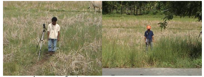
รูปที่ 17 การติดตั้งเครื่องมือวัดระดับเสียงภายนอกห้องโดยสาร
