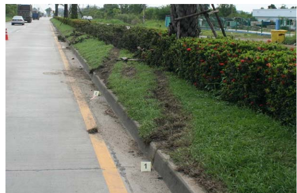
รูปที่ 6 คันหินที่ส่งผลต่อความรุนแรงของอุบัติเหตุ
