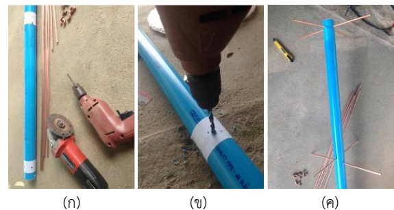
รูปที่ 14 ขั้นตอนบางส่วนในการสร้างสายอากาศแบบ QFH แบบที่ 2 (ก) เครื่องมือตัดและเจาะ (ข) การเจาะ (ค) การยึดท่อทองแดงกับแกนกลาง
