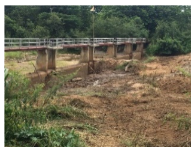
รูปที่ 24 การทับถมของตะกอนหน้าฝายดินดำ
