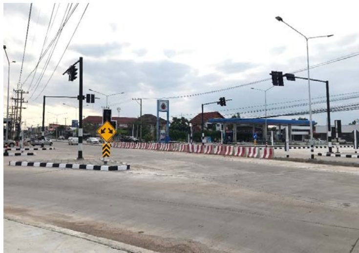
รูปที่ 1 สภาพปัจจุบันของโครงการก่อสร้างทางหลวงชนบท มห.4040
