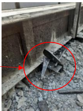
รูปที่ 3 การประกอบแบบหล่อไม่สนิท
