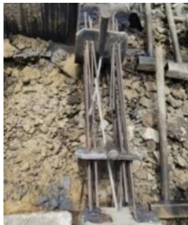
รูปที่ 2 ลวดโครงสร้างภายในเสาไฟฟ้า
