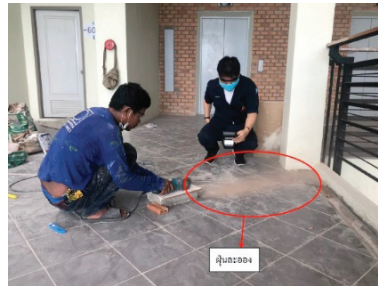
ภาพที่ 12 การทดสอบต้นแบบอุปกรณ์สำหรับงานตัดพื้นกระเบื้อง
