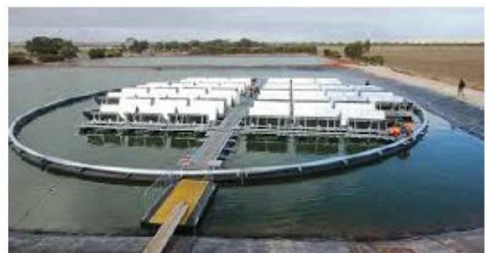
ภาพที่ 3 ระบบผลิตไฟฟ้าจากเซลล์แสงอาทิตย์แบบลอยน้ำที่มีระบบติดตามแสงอาทิตย์ [9]
