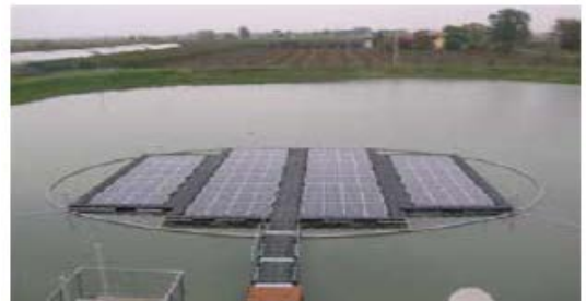
ภาพที่ 2 ระบบผลิตไฟฟ้าจากเซลล์แสงอาทิตย์แบบลอยน้ำที่ไม่มีระบบติดตามแสงอาทิตย์ [9]
