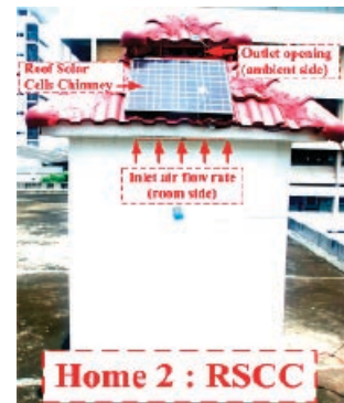
รูปที่ 3 บ้านจำลองที่ติดตั้งปล่องหลังคาโซลาร์เซลล์ระบายอากาศ (Home 2: RSCC)
