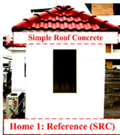
รูปที่ 1 บ้านจำลองที่ติดตั้งหลังคาคอนกรีตทั่วไป (Home 1: SRC)
