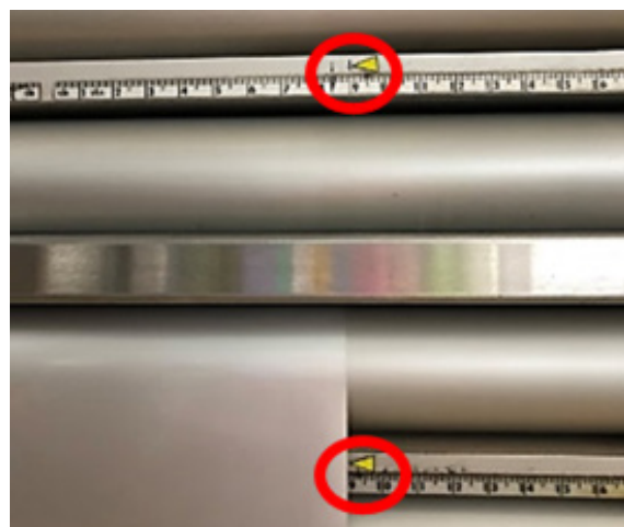
รูปที่ 16 การติดสัญลักษณ์บริเวณจุดต่อฟอยล์
