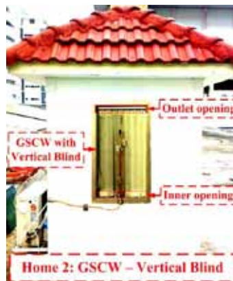
รูปที่ 3 บ้านจำลองที่ติดตั้งหน้าต่างกระจกใสธรรมดา ชั้นเดียวและมีม่านเกล็ดแนวตั้ง (SG-VB) และปล่องกระโจมระบายอากาศที่ติดตั้งม่านเกล็ด แนวตั้ง (GSCW-VB)
