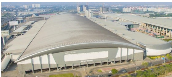
รูปที่ 1 ตัวอย่างอาคารชาเลนเจอร์ฮอลล์ เมืองทองธานี เป็นอาคารเตี้ยขนาดใหญ่ หลังคาโค้ง ซึ่งยังไม่มีระบุในมาตรฐาน มยผ.1311-50 [7]
