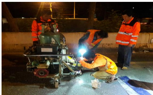
ก. การเตรียมการก่อนตีแถบเส้นชะลอ ความเร็ว
