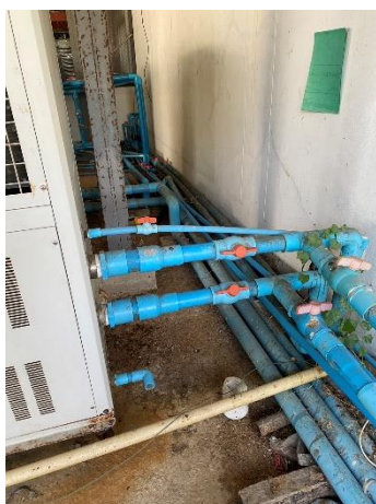
(ก) ท่อน้ำหล่อเย็นก่อนปรับปรุง
