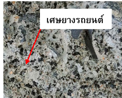
(ข) การกระจายตัวของเศษยางในคอนกรีต
