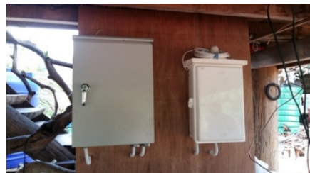
รูปที่ 10 อุปกรณ์อิเล็กทรอนิกส์ในภาชนะกันน้ำในบ่อไต้ดิน การติดตั้งอุปกรณ์สื่อสารที่สถานีทวนสัญญาณและศูนย์แจ้งเตือนข่าวสาร
