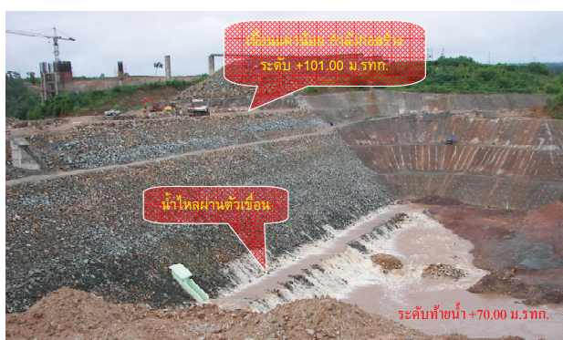
รูปที่ 7 ด้านท้ายน้ำเขื่อนแควน้อยเมื่อมีน้ำหลากไหลผ่าน
