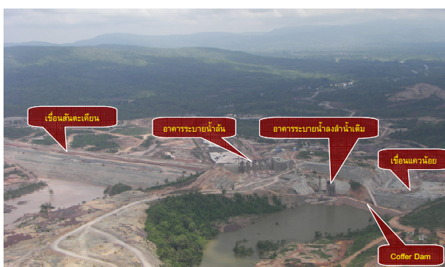
รูปที่ 5 ภาพถ่ายทางอากาศขณะก่อสร้างเขื่อนแควน้อยก่อนรับปริมาณน้ำหลาก (16/5/2550)
