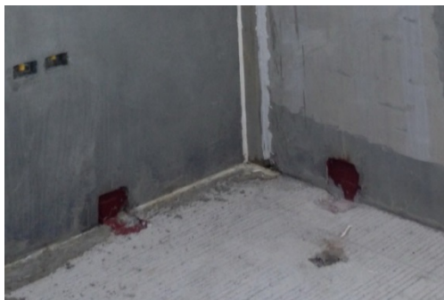
รูปที่ 6 รายละเอียดจุดต่อระหว่างผนังรับแรงชั้นล่างและชั้นบนโดยใช้การเชื่อมระหว่างแผ่นเหล็กและเหล็กฉาก
