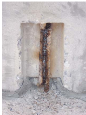
รูปที่ 5 รายละเอียดจุดต่อระหว่างผนังรับแรงชั้นล่างและชั้นบนโดยใช้การเชื่อมระหว่างเหล็กเดือยกับเหล็กเดือย
