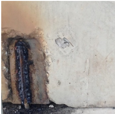
รูปที่ 7 รายละเอียดจุดต่อระหว่างผนังรับแรงชั้นล่างและชั้นบนโดยใช้การเชื่อมระหว่างแผ่นเหล็กกับเหล็กเดือย
