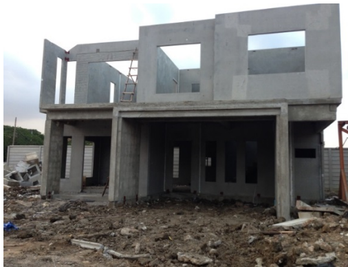
รูปที่ 2 การก่อสร้างบ้านพักอาศัยระบบผนังรับแรงในประเทศไทย
