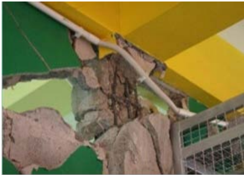
รูปที่ 1 ลักษณะความเสียหายที่เกิดขึ้นเกิดกับโครงสร้างเสา
