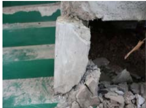
รูปที่ 1 ลักษณะความเสียหายที่เกิดขึ้นเกิดกับโครงสร้างเสา
