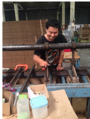
รูปที่ 3 การติดตั้งจากประดอง การติดตั้งสลักยึดแบบกันคลาย
