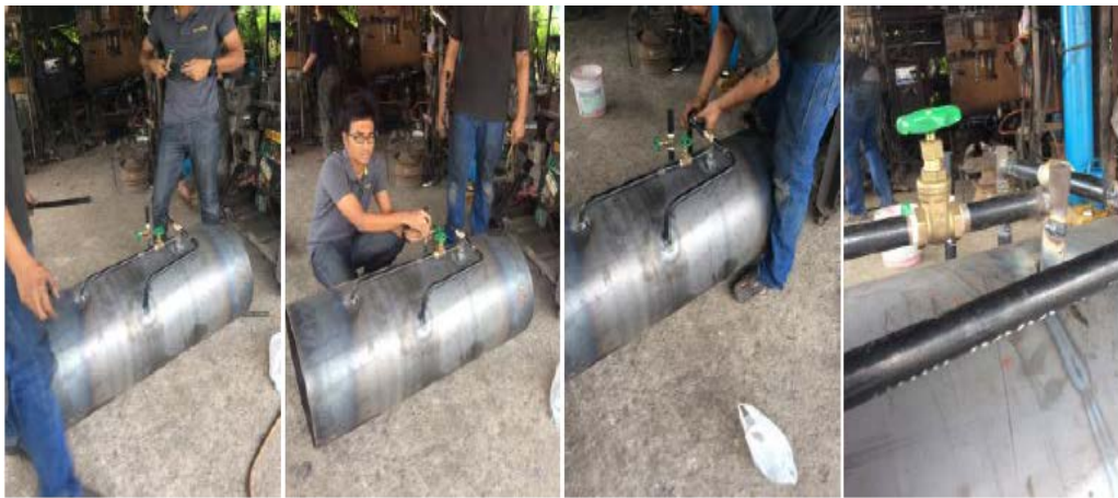
รูปที่ 5 การเชื่อมประกอบท่อน้ำและท่อไอน้ำ
