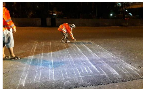
ข. การกำหนดขนาดความกว้างและระยะห่างของแถบเส้นชะลอความเร็ว
