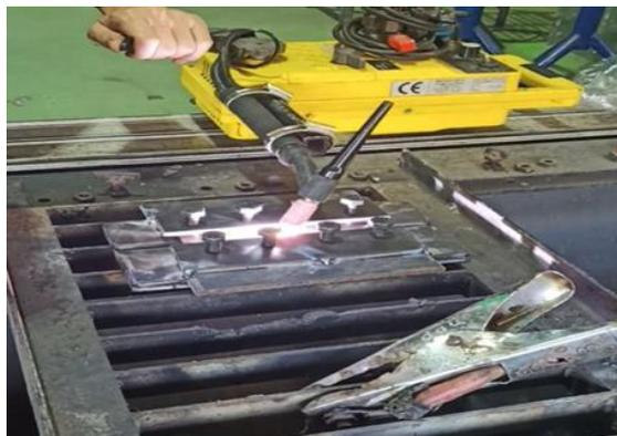
รูปที่ 4 เชื่อมชิ้นงานทดสอบ
