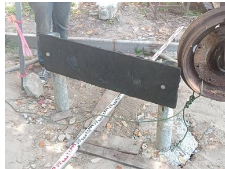
(ข) การติดตั้งราวกันอันตรายชนิด ABS
